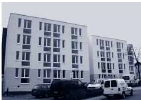
Die Eulenbaumstraße mit neuer Außenfassade.
