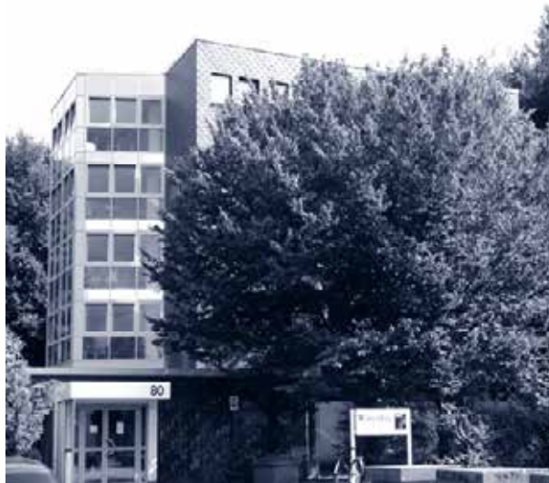
Das AKAFÖ hat in den Umbau des C-Turms an der Laerholzstraße 80-84 bereits über 1,2 Millionen Euro investiert.
