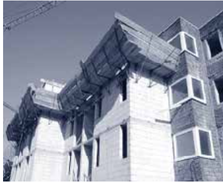
Durch die Anbauten wurde die Wohnfläche der Appartements immens vergrößert.
