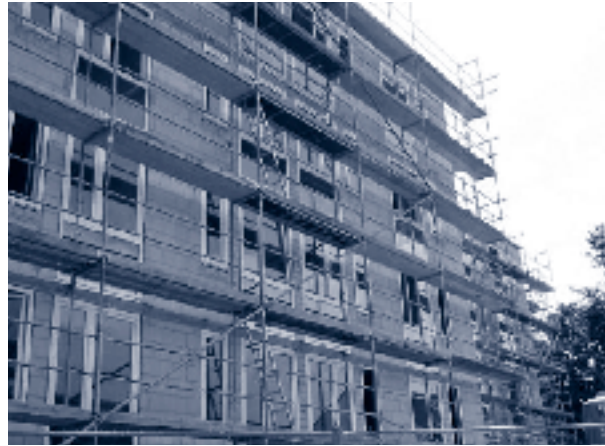
Die Wohnbereiche des AKAFÖ-Wohnheimes Eulenbaumstraße werden erweitert, die Wohneinheiten modernisiert.
