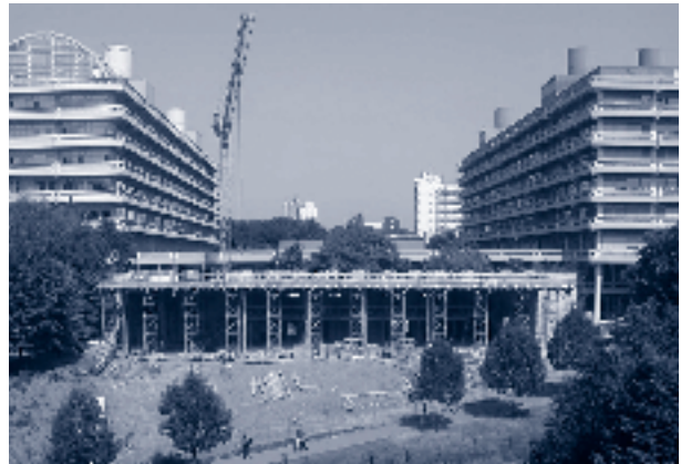
Anfang September war das Querforum West noch im Rohbau. Hier werden ab November 380 Sitzplätze angeboten. Die gastronomische Versorgung erfolgt durch daneben errichtete Container.
